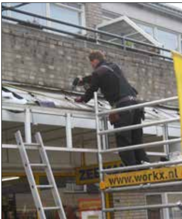
Renovatie winkelcentrum Brouwhorst begonnen.
